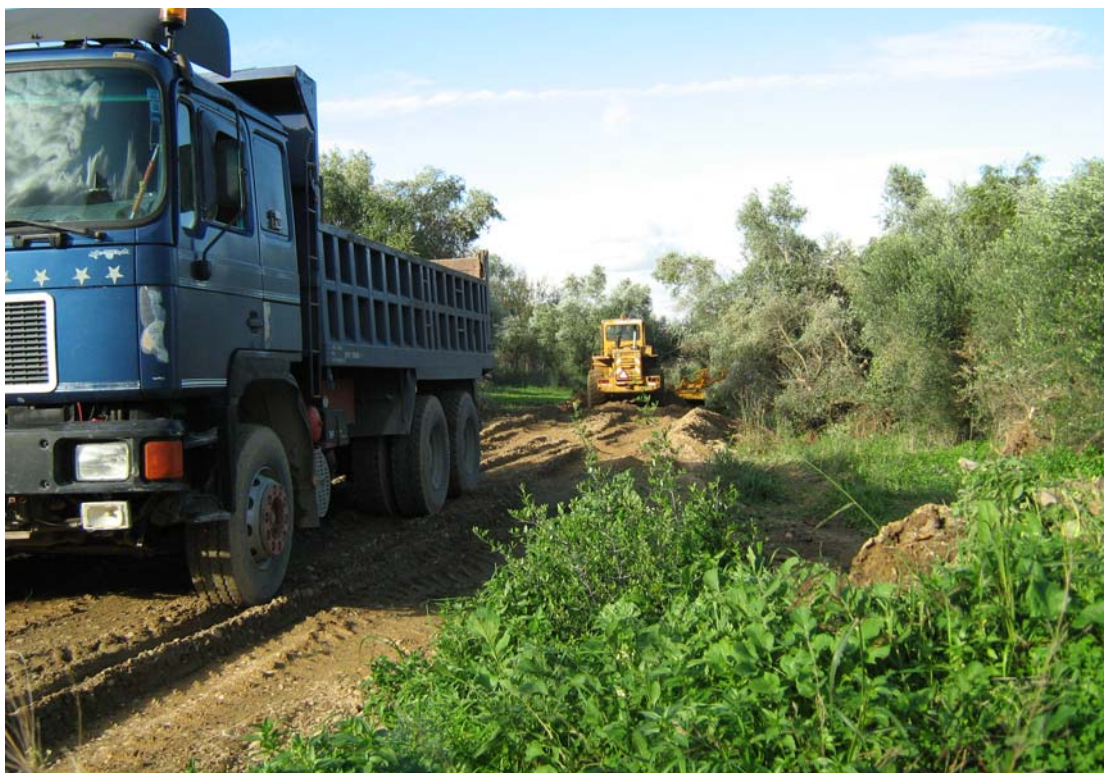
Φωτο 1 (άνω) & 2 (κάτω) : Κατασκευή και διαμόρφωση οδού προσπέλασης σε επίχωμα απο κοκκώδες υλικό (αμμοχάλικο) στο εσωτερικό του οικοπέδου, για την προσέγγιση των θέσεων έρευνας.
