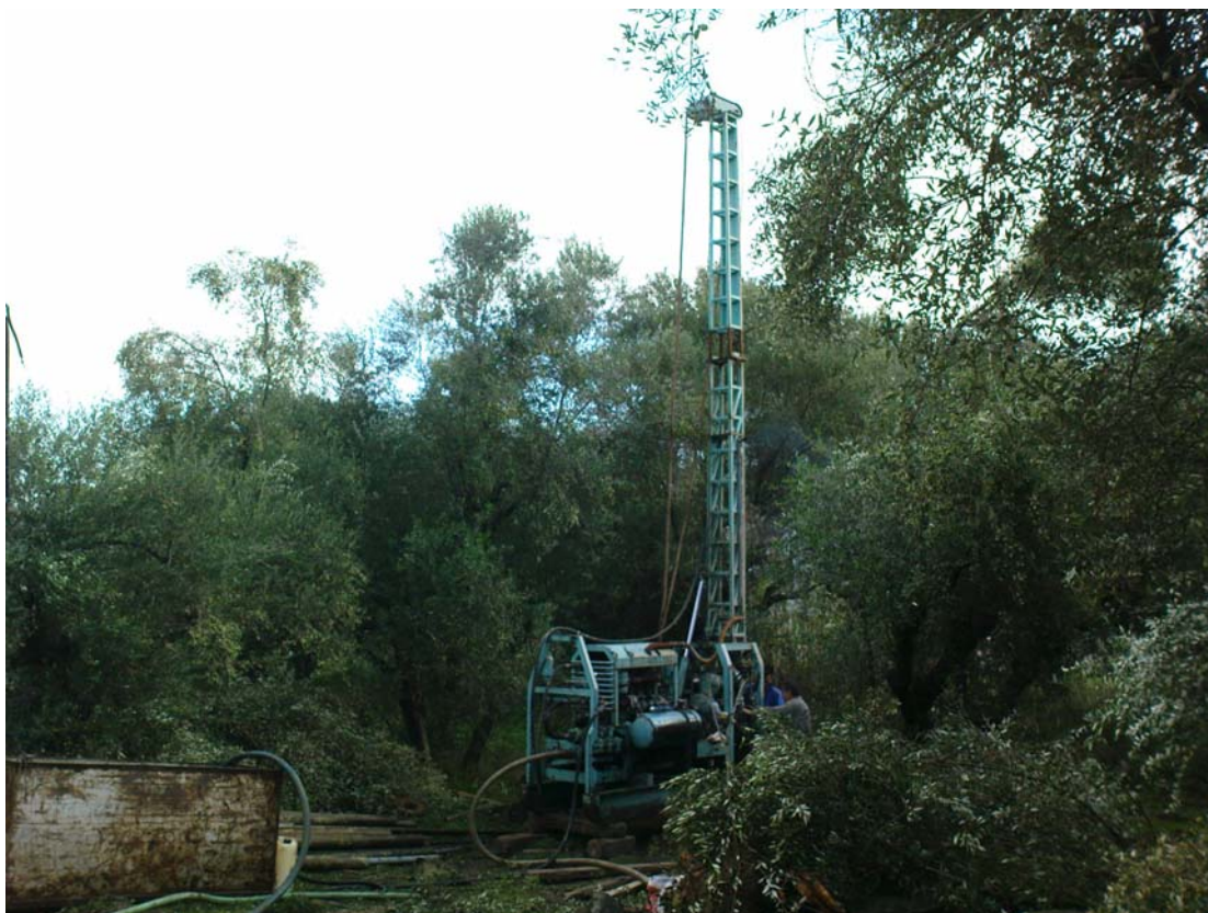
Φωτο 11 : Εκτέλεση δειγματοληπτικής γεώτρησης Γ2.
