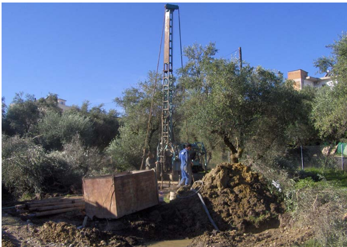
Φωτο 18 : Εκτέλεση δειγματοληπτικής γεώτρησης Γ3.
