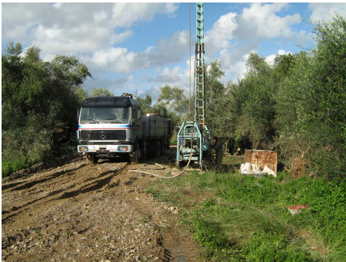
Φωτο 5 : Εκτέλεση δειγματοληπτικής γεώτρησης Γ1.
