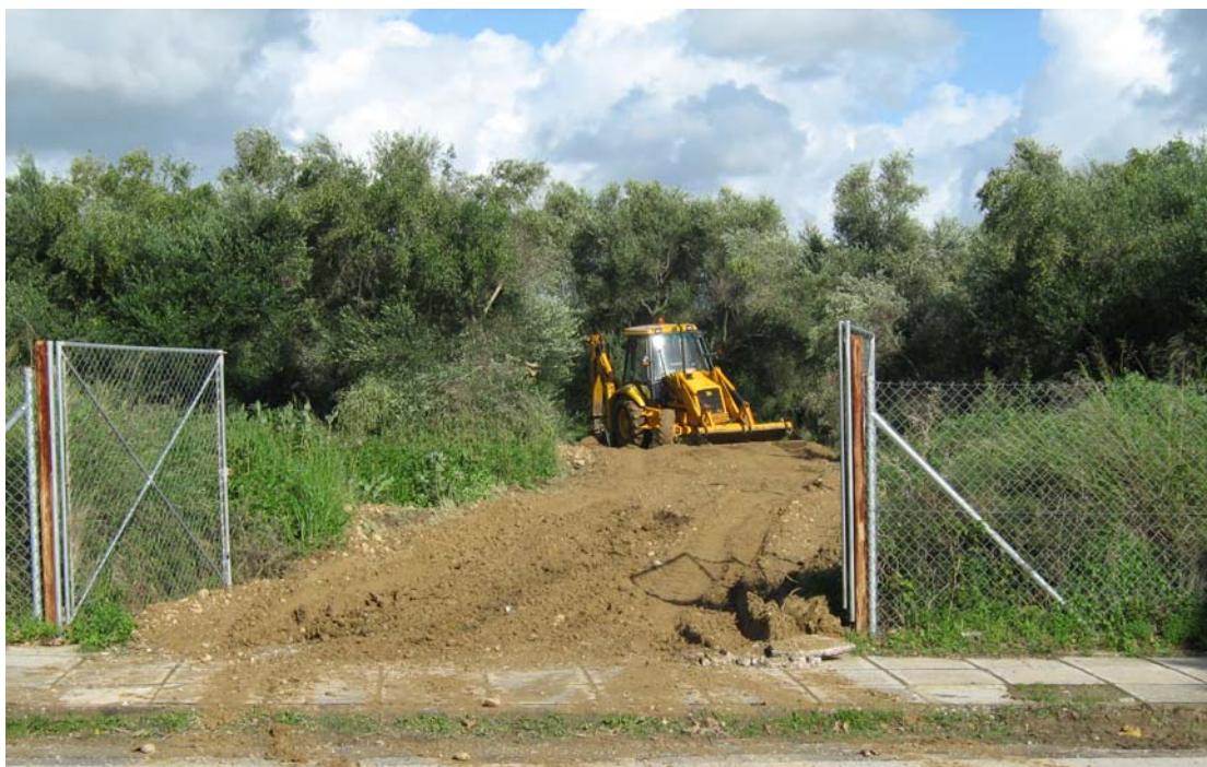
Φωτο 1 (άνω) & 2 (κάτω) : Κατασκευή και διαμόρφωση οδού προσπέλασης σε επίχωμα απο κοκκώδες υλικό (αμμοχάλικο) στο εσωτερικό του οικοπέδου, για την προσέγγιση των θέσεων έρευνας.
